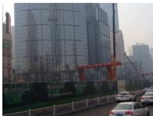
位于青岛市内的地铁施工现场
